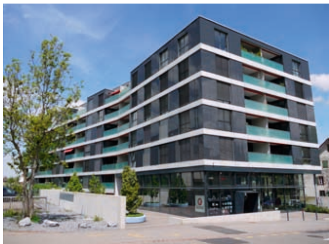
Moderne Wohnüberbauung am Bahnhof in Unterwetzikon [Quelle: SKW]
