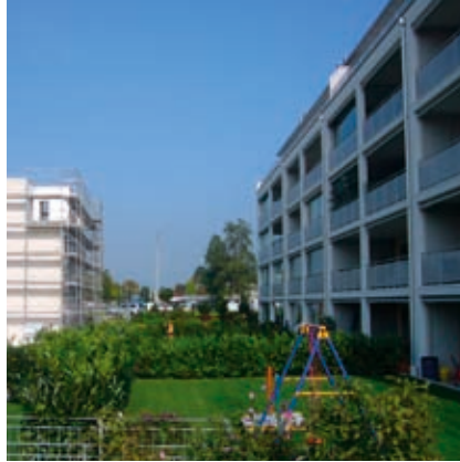
Moderner Wohnungsbau [Quelle: yz]
