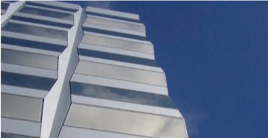
Fassadendetail SIA Hochhaus, Zürich (Romero und Schaeffle, Zürich) [Quelle: yz]
