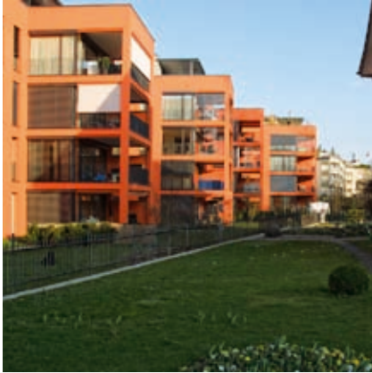
Moderner Wohnungsbau [Quelle: Klaus Hoffmann]
