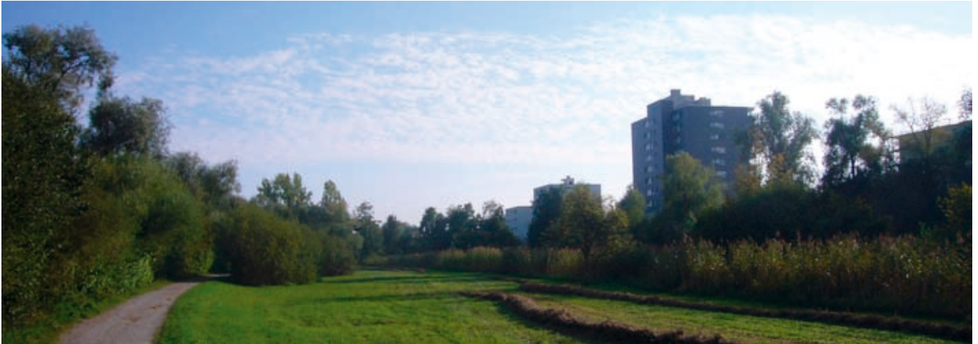
Bestehendes Hochhaus in Wetzikon [Quelle: yz]
