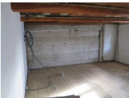
Bohlenstube – Nachbarhauswand und Vorderhauswand
