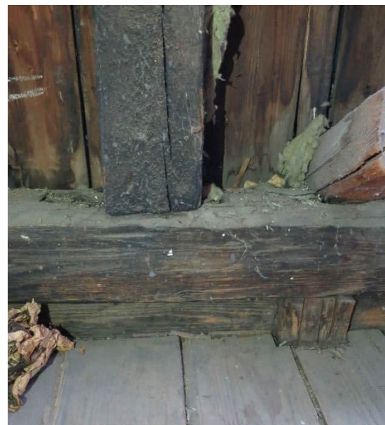
Nördliche Giebelwand des Nachbarhauses. Detail. Verblattungen mit Holznägeln Südliche Aussenwand Ständerbaukonstruktion
