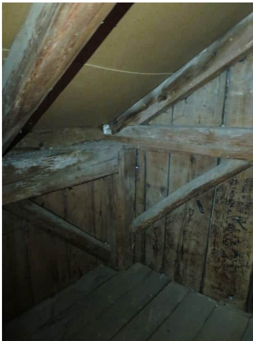
Sichtbare originale Giebelkonstruktion samt Ver- breitung. Zweitverwendete Balken
