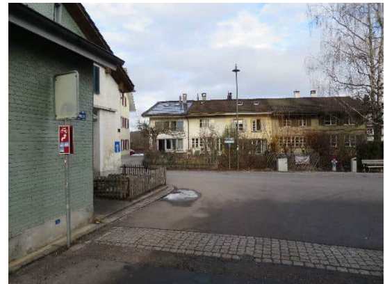
Robenhausen. Flarzhaus in der Dorfstrasse und Motorenstrasse.
