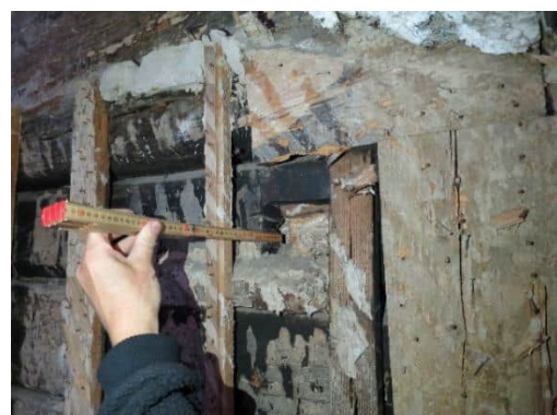
Bohlenwand des Nachbarhauses Dorfstr. 25 – Bereich Küche und Aufgang ins Obergeschoss. Bohlenstärke: 70–80 mm
