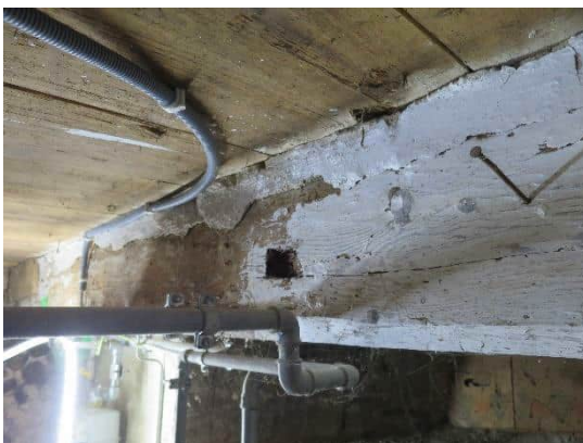
Wohl ursprünglicher Zugang des Wohnteils Nr. 4. Kiesmauerwerk der bis zu 100 cm dicken Mauern mit zweitverwendeten Balken aus dem Umbau von 1843/1864.
